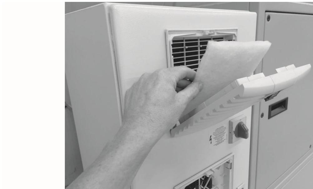
Obr. 57: Výměna filtrů skříňového rozvaděče
